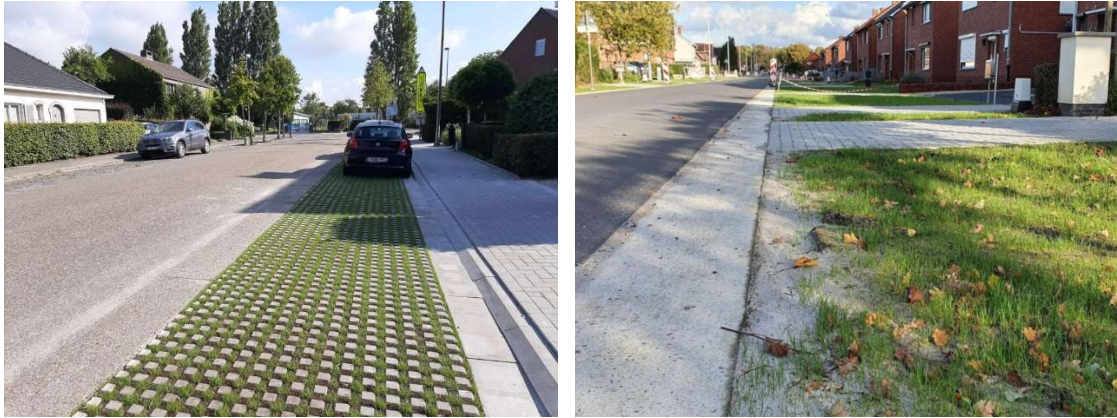
Figuur 32. Voorbeelden van parkeerplaatsen met waterdoorlatende verharding in Temse (links) en ontharde bermen in Beringen (rechts). (Bron: blauwgroenvlaanderen.be)
