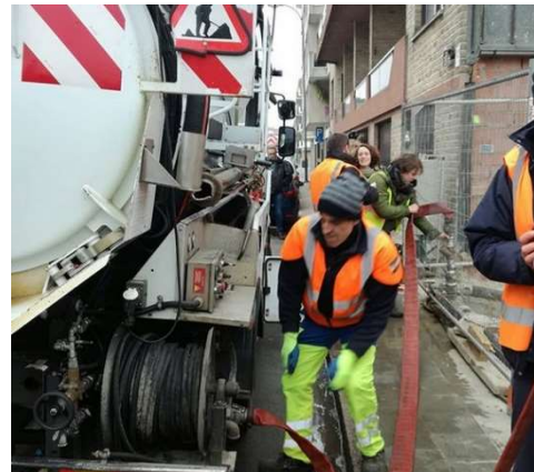
Figuur 33. Hergebruik van bemalingswater: via opslagtanks in Nevele (links, bron: HLN) en vullen van veegwagens in Brussel (rechts, bron: OpenSource Brussels).
